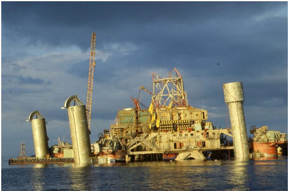
Bilde 7. Alexander L. Kielland i Gannsfjorden Foto: Stavanger A. V. Institutt as.
