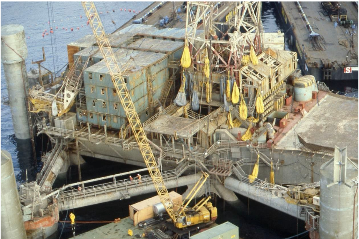
Bilde 9. Deler av plattformdekket. Foto: Stavanger A. V. Institutt as.
